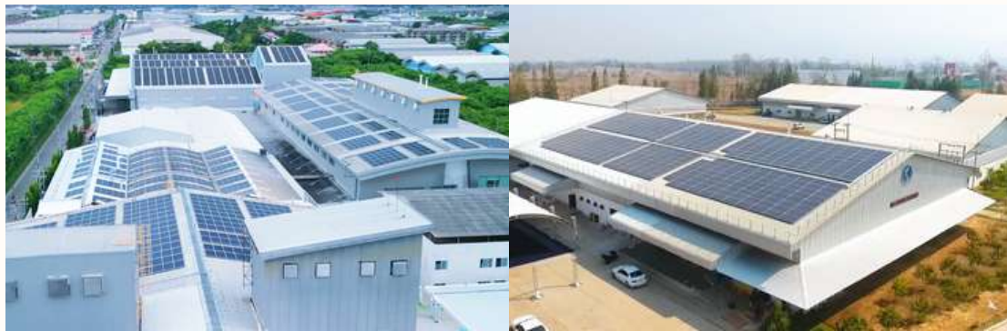
ระบบ Solar Rooftop บนหลังคาโรงงานที่จังหวัดสมุทรปราการและจังหวัดตาก
